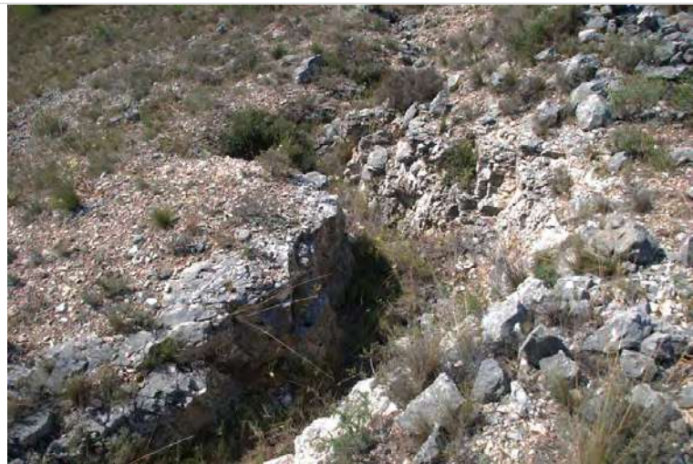
Trinchera tallada en el terreno natural
