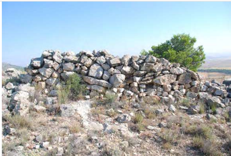
Parapeto en piedra seca
