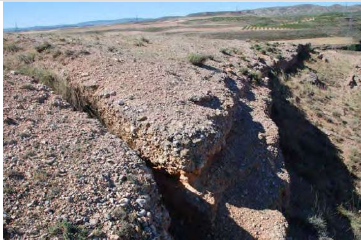
Ramal de trinchera tallado en el terreno
